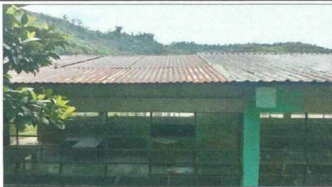
Foto 2: SUSTITUCION DE LAMINAS EN MAL ESTADO
