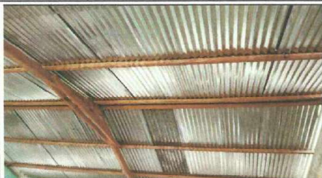
Foto 1: SUSTITUCION DE SOPORTE DE MADERA A METAL
