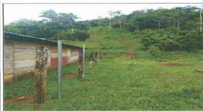
Foto 3: SUSTITUCION DE MALLA INSERVIBLE Y POSTES PODRIDOS POR MALLAS NUEVAS Y TUBOS GALVANIZADOS
